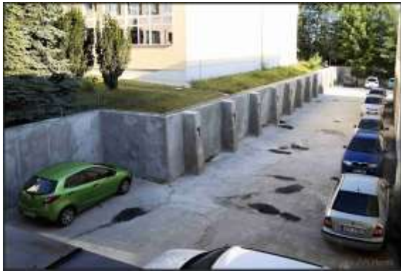
Modernizace školy opěrná zeď pod tělocvičnou
